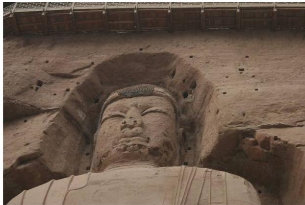
图 5-1 小环境改变导致表层劣化加剧的炳灵寺石窟造像
